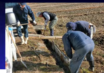
開水路の補修 (NO.27 賀茂農地・水保全会 広域協定運営委員会)
