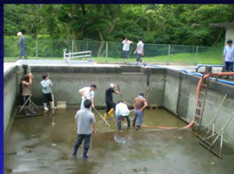
ファームポンドの清掃状況
