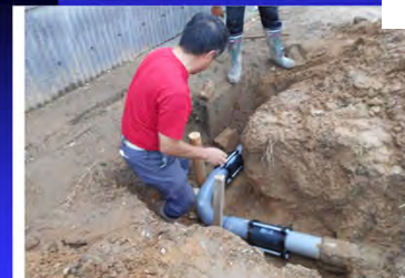
管水路の補修 (NO.16 東赤沢町地域資源保全会)
