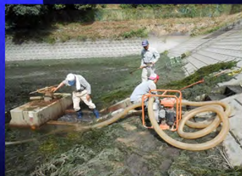
ため池の泥上げ清掃状況
