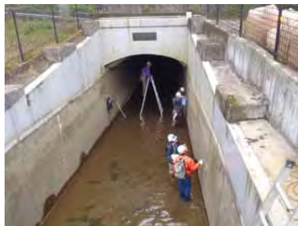
開水路内の劣化調査
