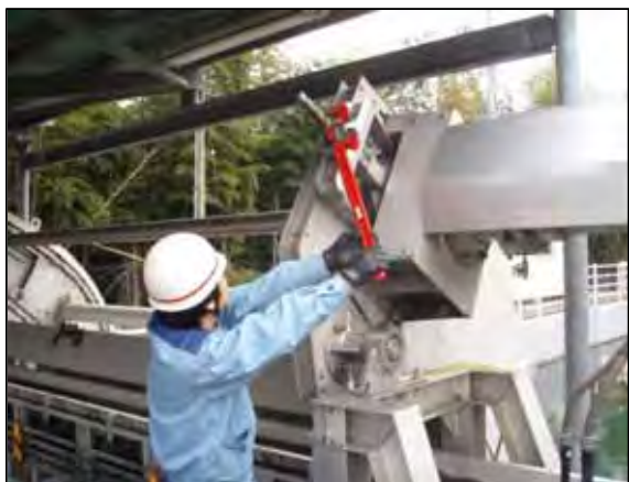
幹線水路除塵機の点検
