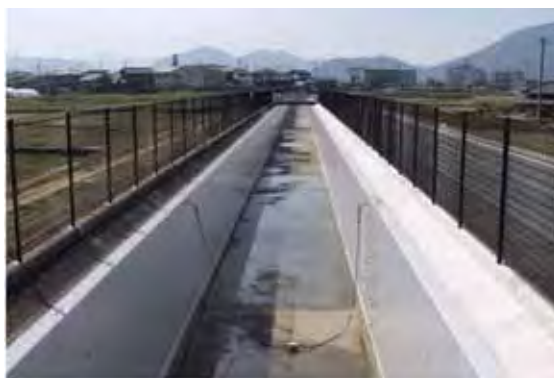
改築後（水路補強完成）
