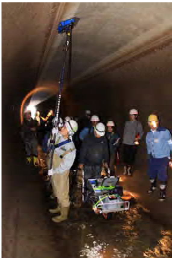
トンネル内の劣化調査
