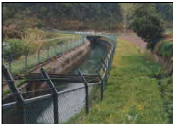
開水路改築 ( 施工前 )
