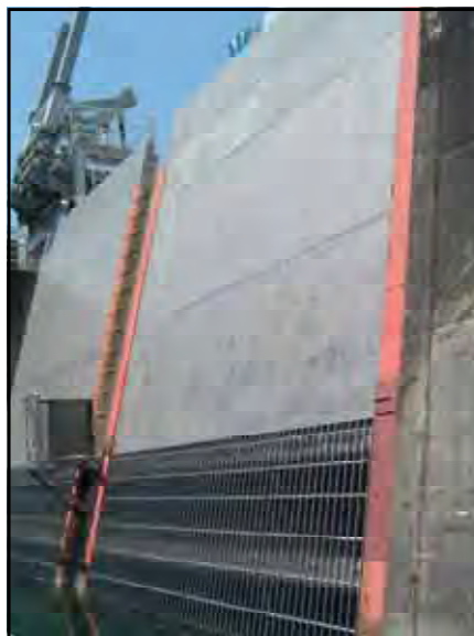
除塵施設改築（施工後）
