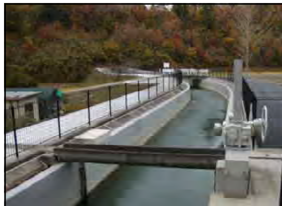
開水路改築 ( 施工後 )
