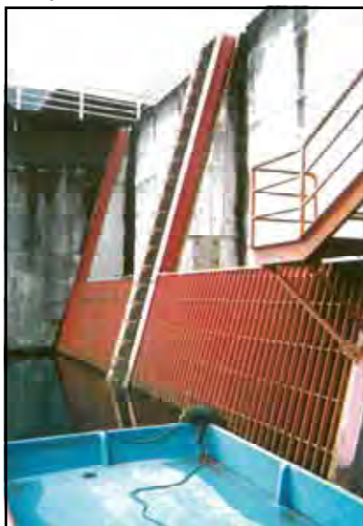
除塵施設改築（施工前）
