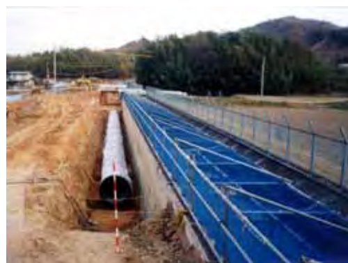
併設水路布設状況
