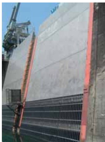
取水工除塵機の更新
