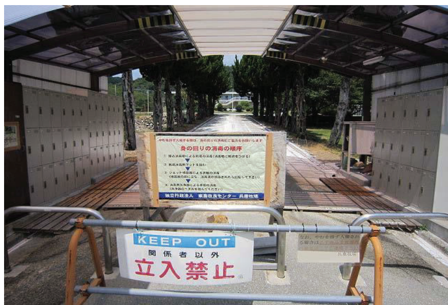
衛生管理区域出入口の設備の一例
