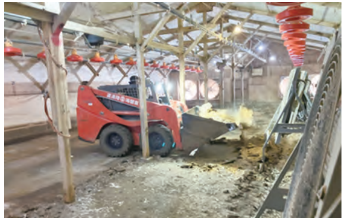
写真：除糞作業（ホイールローダー）
