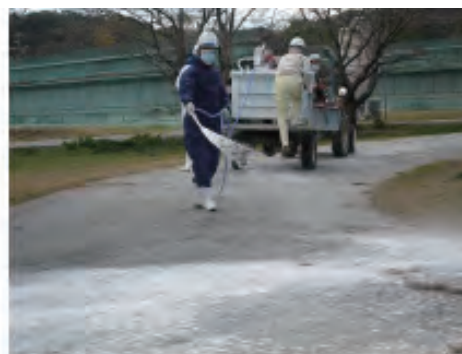
③噴霧機を用いて道路にまんべんなく石灰乳を塗布
