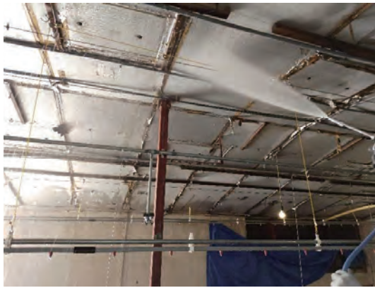
写真：水洗作業（天井）
