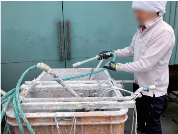
写真：ドロマイト石灰塗布機 水中ポンプ、ホース、散水ノズルを組み合わせ て自作しています。
