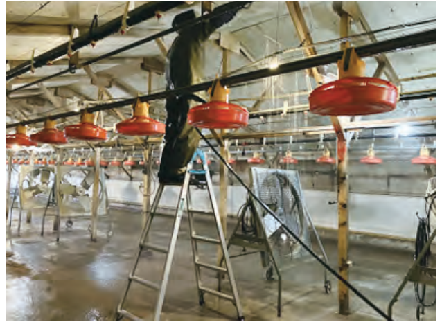
写真：天井・梁の水洗
