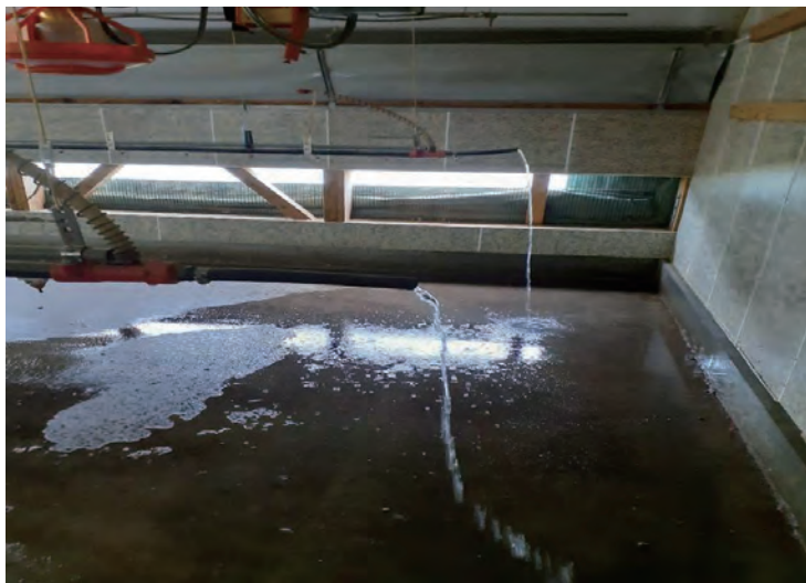
写真：給水管内の洗浄
