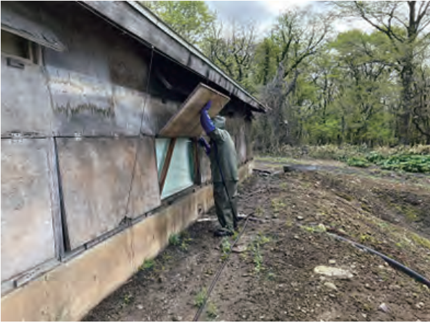
写真：鶏舎外壁の水洗
