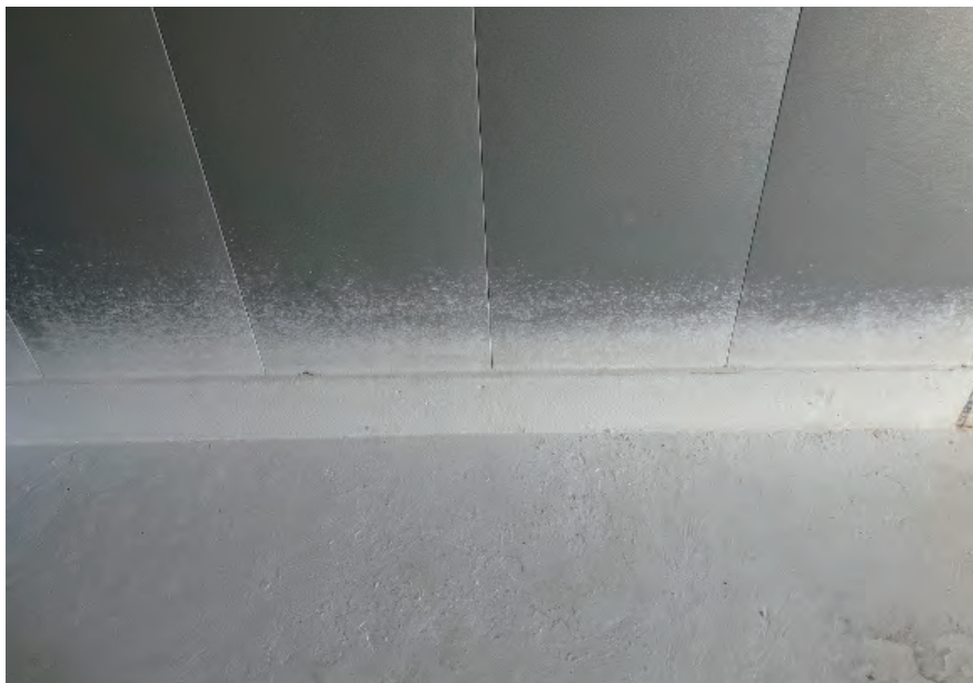
写真：石灰塗布後の鶏舎内床面（腰板部） 石灰乳をまんべんなく塗り、床面を消毒するとともにひび割れ等を塞いでいます。
