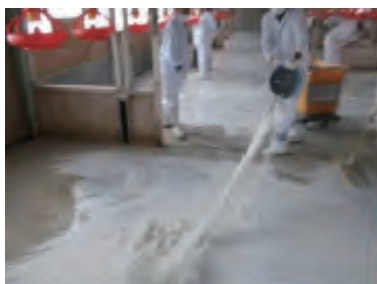
③ポリ容器を台車で鶏舎内へ運び、バケツで石灰乳を床に撒く
