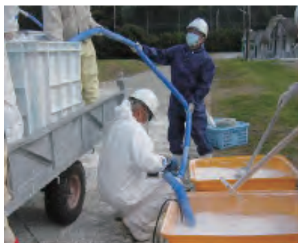
②水中ポンプを用いて、車両に積載したタンクへ石灰乳を充填
