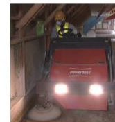
写真：除糞作業（搭乗式清掃機）
