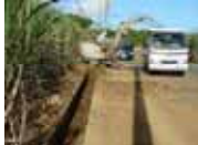
側溝の泥上げ
