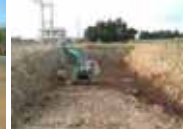
沈砂池の土砂上げ
