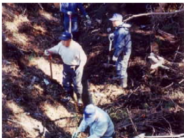
水路の補修・整備作業
