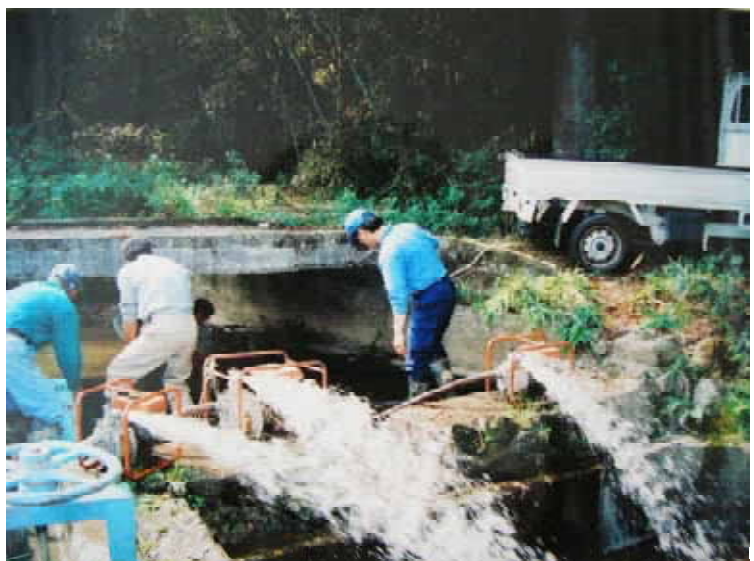
用水路改良工事
