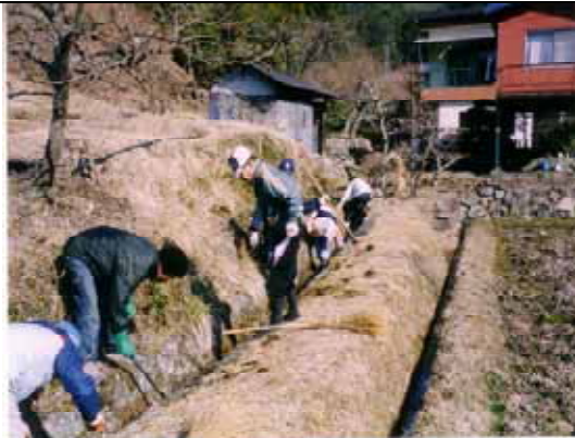
水路整備 水路の土出し・目地埋め
