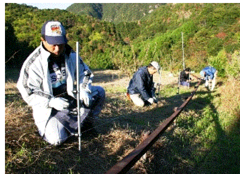
鳥獣害防護柵の設置
