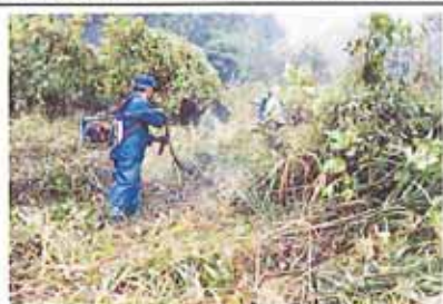
荒廃地の復旧作業
