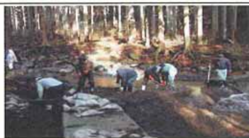
老朽化した取水堰の補修
