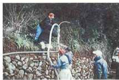
農業用水ホースの交換、石垣の整備
