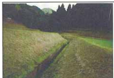
水路・畦畔管理状況
