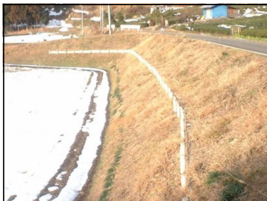
法面中段の足場
