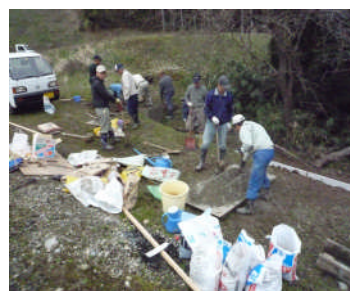
用排水路の改修工事
