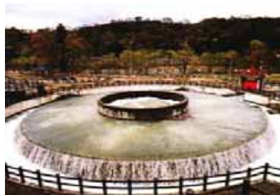
円筒分水工の全景
