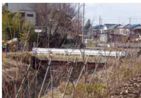
住宅地を流下する用水路
