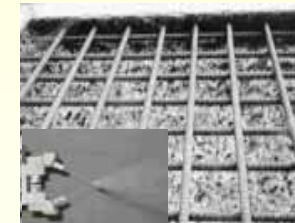
高速水噴流を衝突させコンクリートのはつり深さを制御し、部分補修を実施
