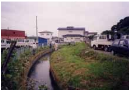
住宅地を流下する用水路
