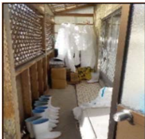
＜離乳豚舎前室の整備＞
