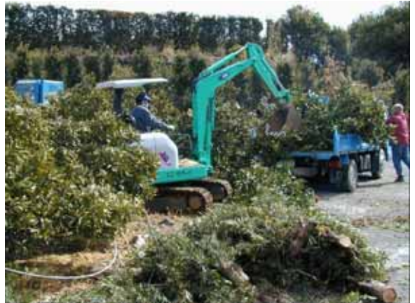
園内道設置作業
