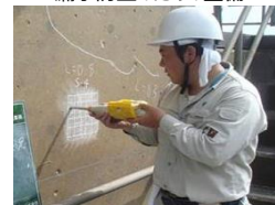
老朽化した施設の機能診断
