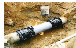
漏水防止のための整備
