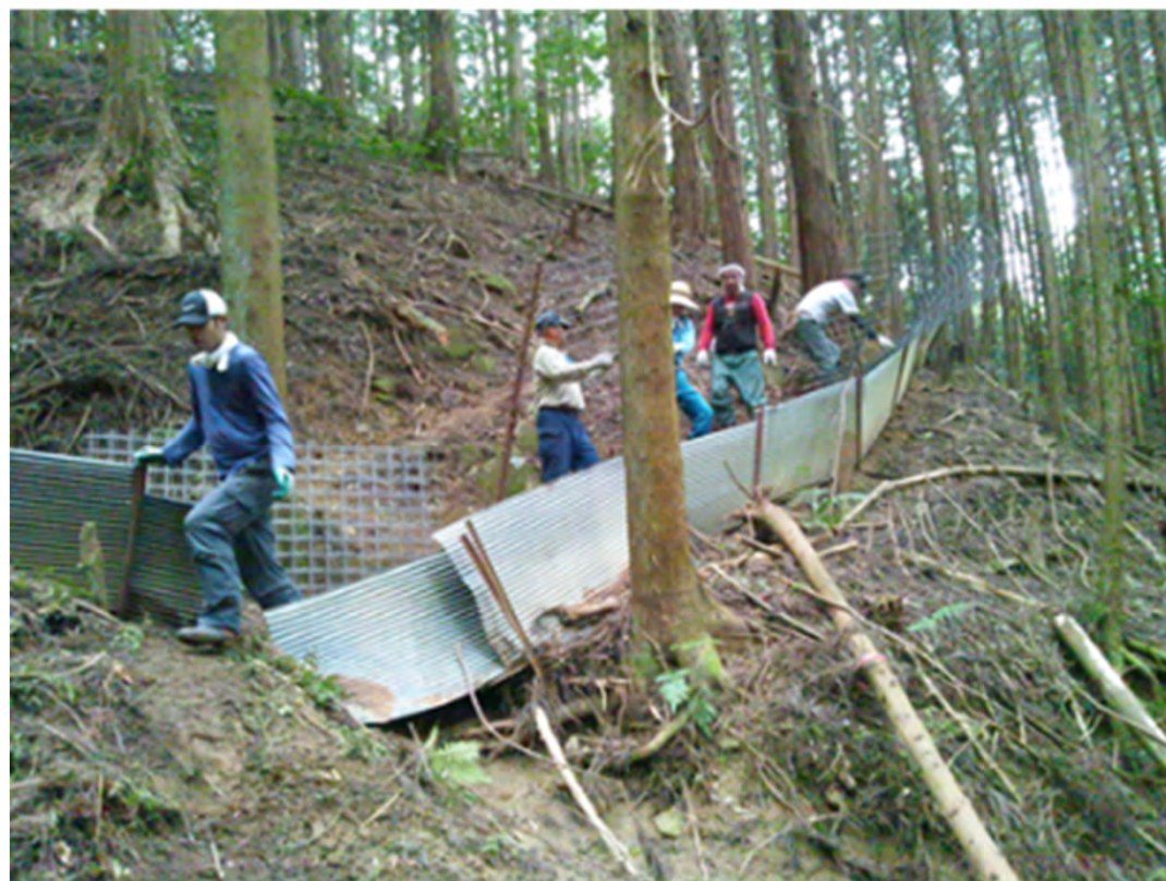
全長 6 kmの獣害柵を設置
