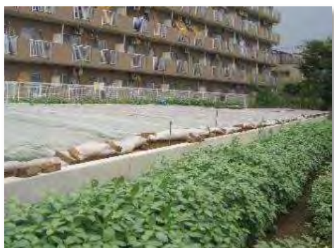
土砂流出対策の土留め
