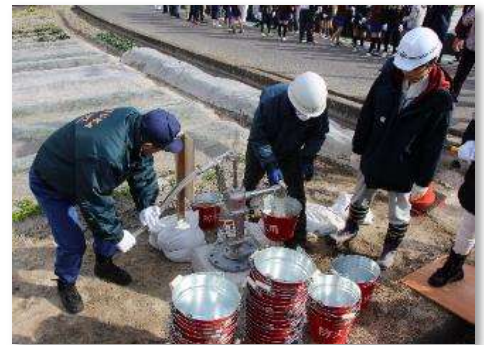
防災兼用井戸の整備
