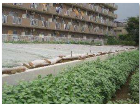
土砂流出対策の土留め
