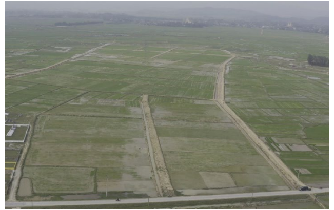
図-9 整備後全景
