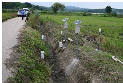
Lampangでのソーラーパネル設置状況
