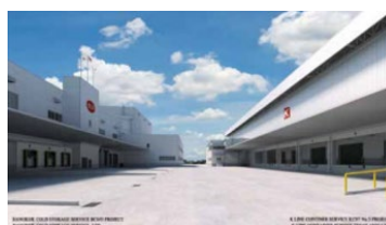
【海外の冷蔵・冷凍物流倉庫】
