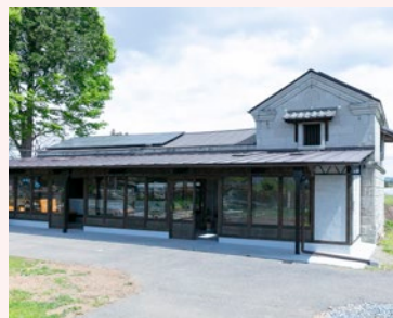
蔵を改修した農家ホテルの外観
