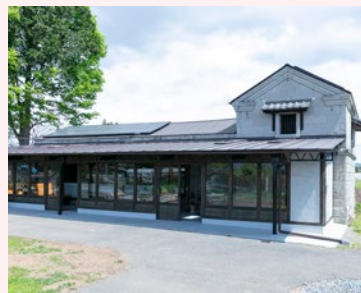
蔵を改修した農家ホテルの外観
