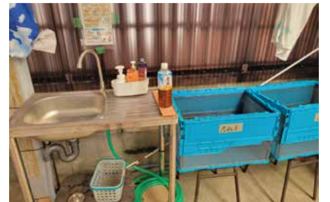
▲新設した手洗い用の水道
