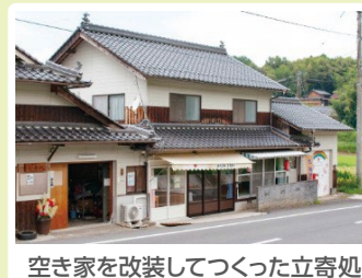
空き家を改装してつくった立寄処
