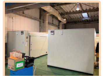
「立川ストックヤード」の設備
