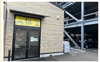
北長瀬コミュニティフリッジの外観
