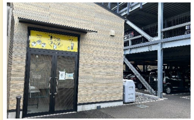
北長瀬コミュニティフリッジの外観
