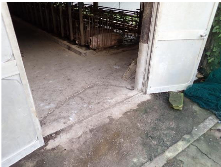
豚舎入口。消毒槽、豚舎専用長靴なし
