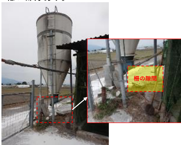
障害物により柵が設置ない箇所があるため隙間あり。
