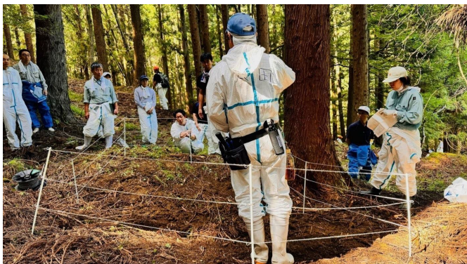
電気柵を非平面に最低地上高15cmとなるように設置
