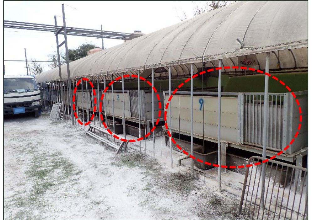
ユニットタイプの飼育箱。天井はあるが 周囲に壁面、ネット等は未設置
