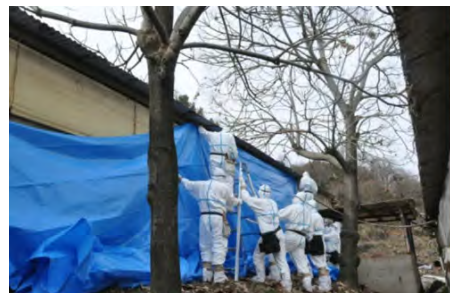
畜舎へのブルーシート設置
