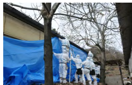
畜舎へのブルーシート設置
