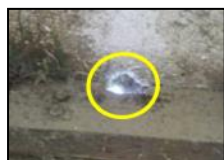
壁等の破損の修繕
