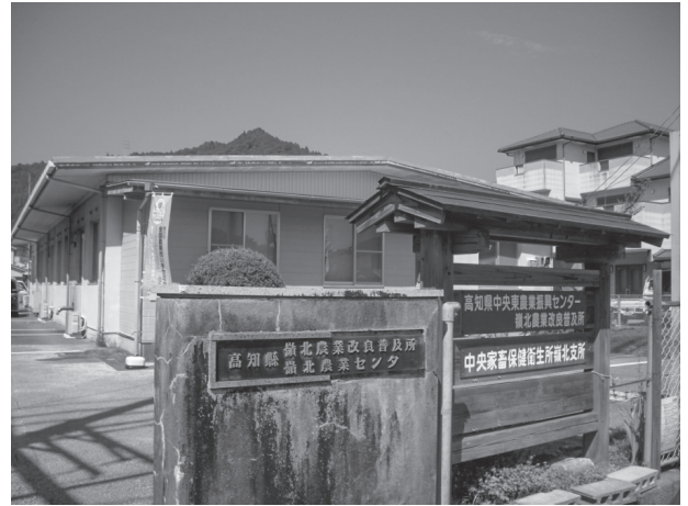
嶺北支所の外観
