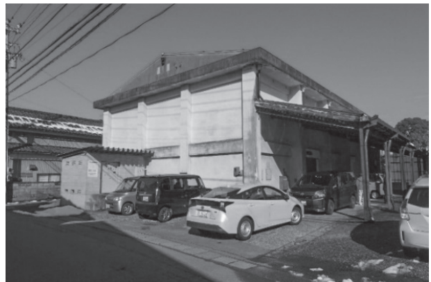
図1 新備蓄庫外観
