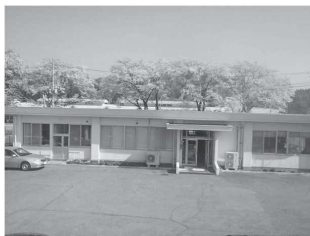
吾妻家畜保健衛生所外観
