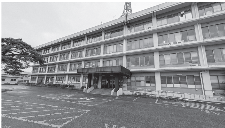
上越家畜保健衛生所の外観（1階部分）
