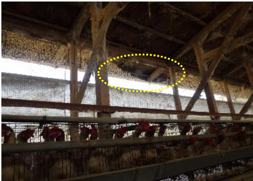
鶏舎側面の防鳥ネットの破損
