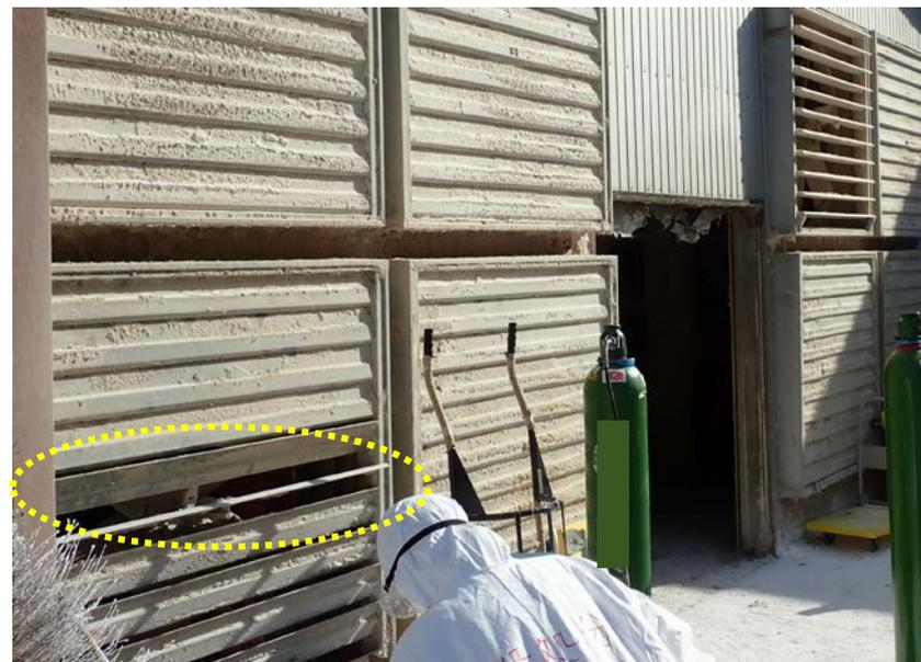
換気扇の開閉弁が閉じない状態
