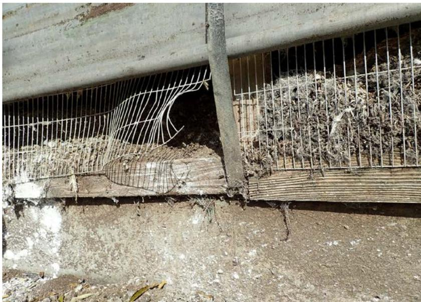
鶏舎外壁下部の金網の破損
