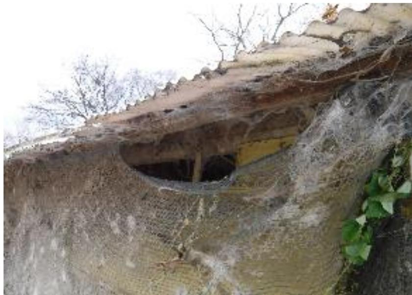
鶏舎側面の防鳥ネットの破損
