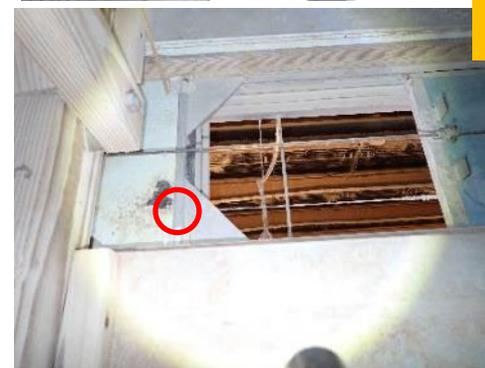
鶏舎側面の入気口木板の破損と天井裏の中型哺乳動物のものと思われる糞
