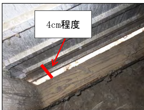
※側面壁と基礎部分の隙間 (内側から撮影)
