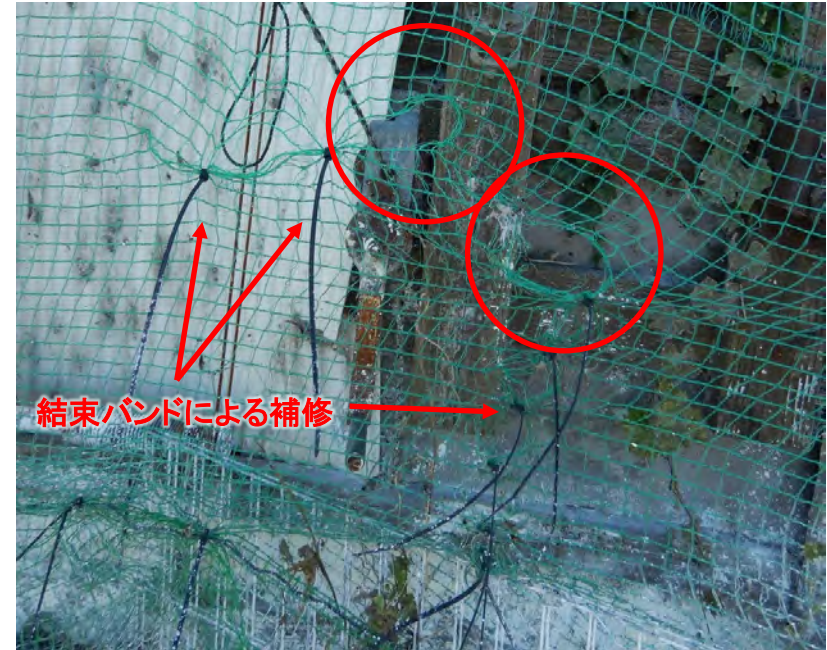
防鳥ネットの補修部分からさらに開けられた穴(赤丸部分)
