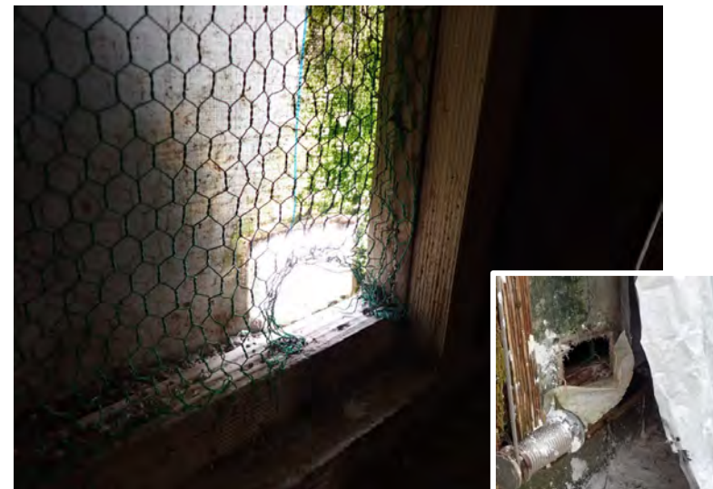
鶏舎の金網の破損部位。小動物が出入りした痕跡あり
