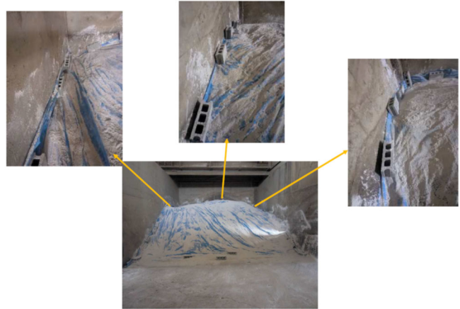
封じ込め後の状況
