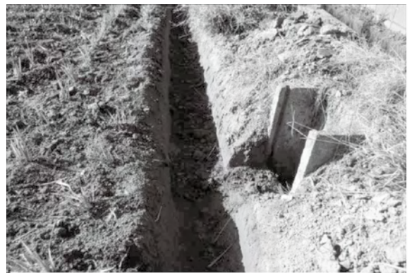
写真2 排水口とつないだ周囲溝
