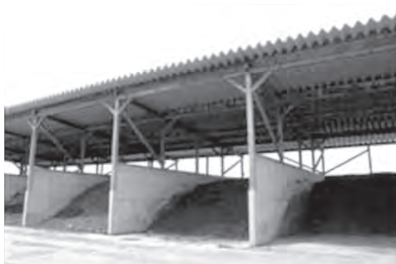
法人の敷地内に整備した堆肥舎
