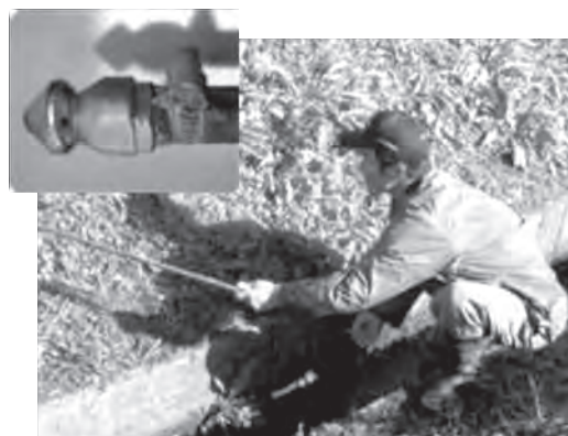
本暗渠内のそうじ(左上は専用ノズル)
