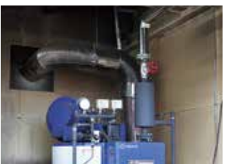
蒸気ボイラーで食品残渣を殺菌
