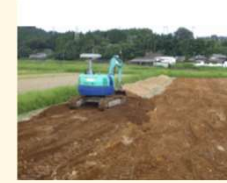
土層改良（客土）
