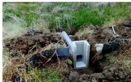
排水マスと排水パイプの埋設
